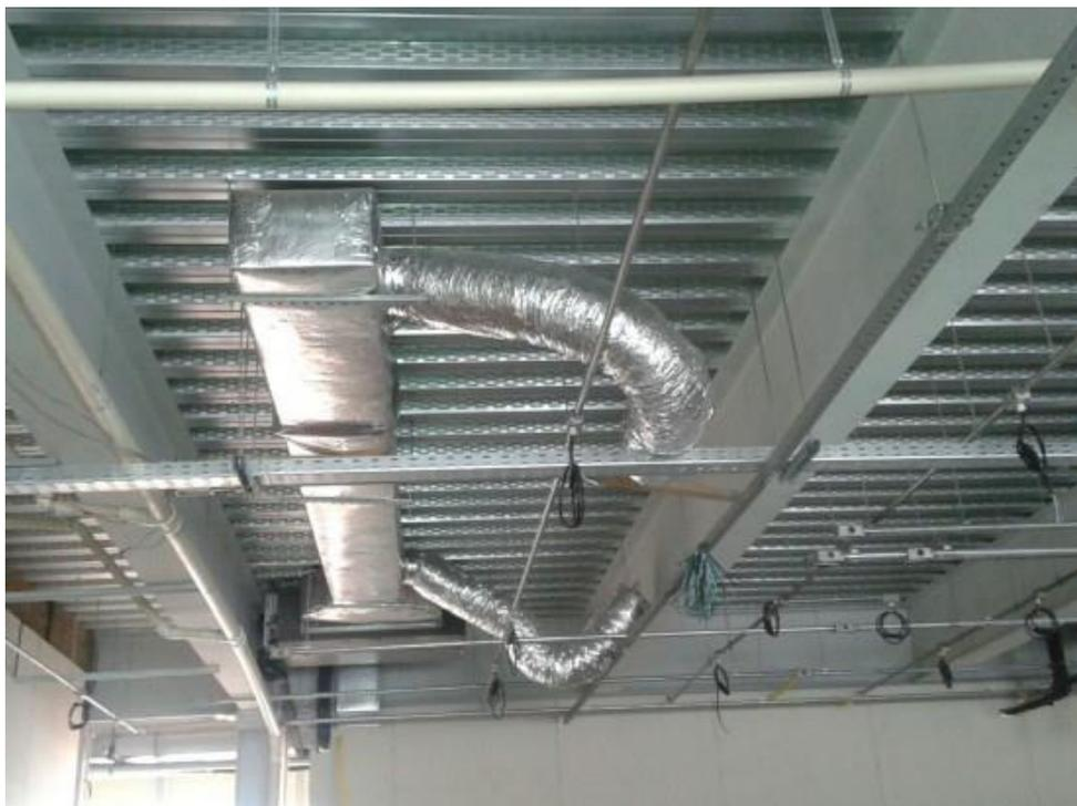
**Figura 32:** Exemplo de instalação de rede de dutos sobre o forro
